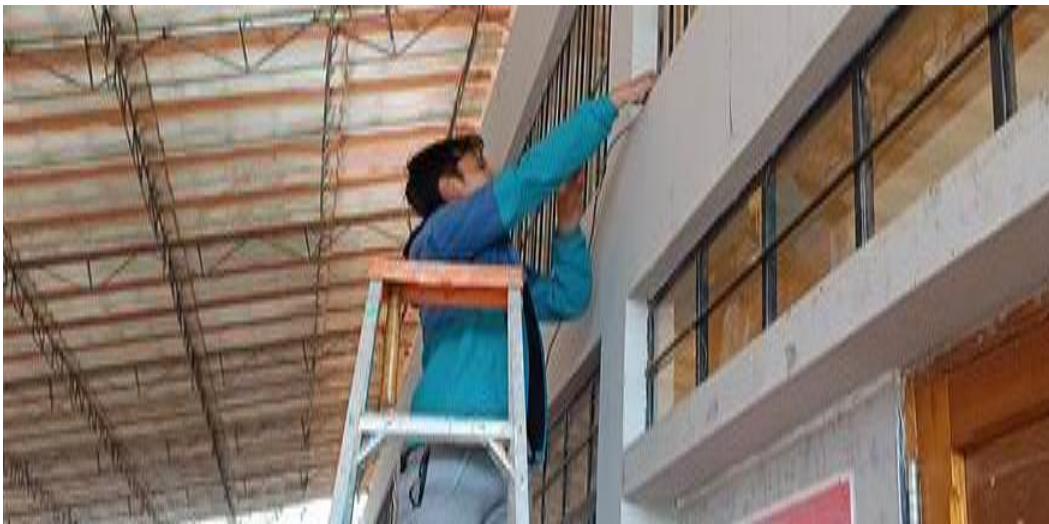
Figura 30 cableado al punto de la cámara 6
