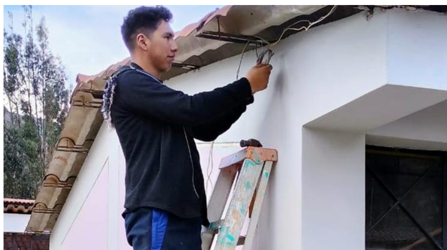
Figura 20 instalación de cámaras 4.
