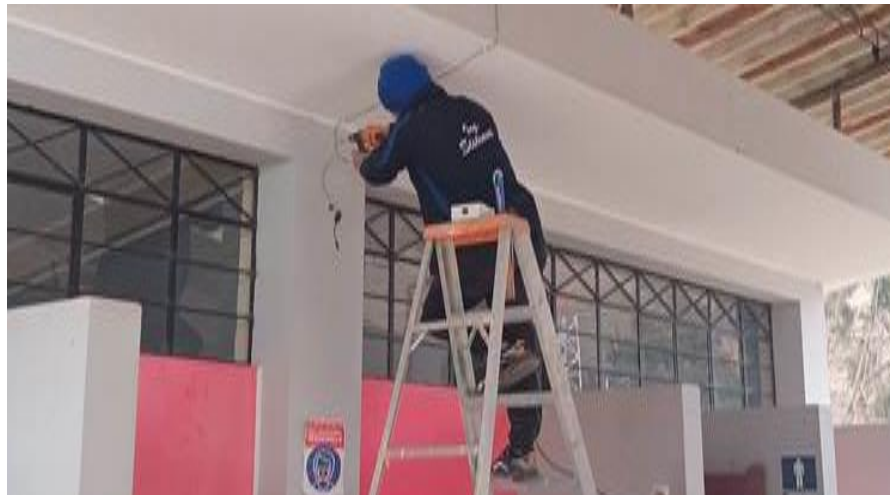
Figura 19 Instalacion de la cámara 3
