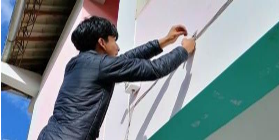
Figura 29 Cableado de la red
