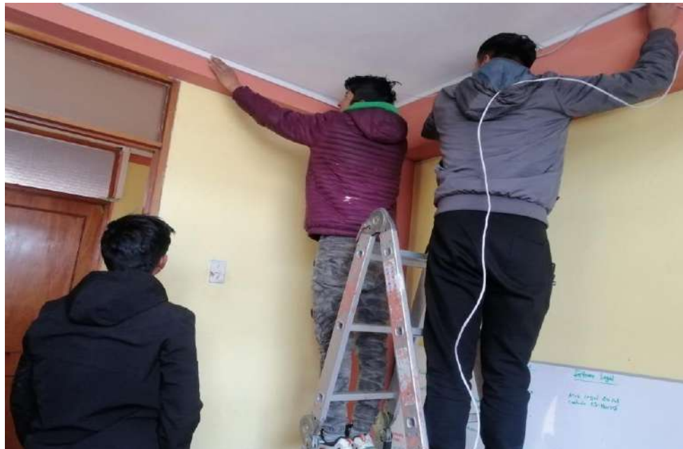
Figura 18. Colocando el cableado UTP en las canaletas respectivas
