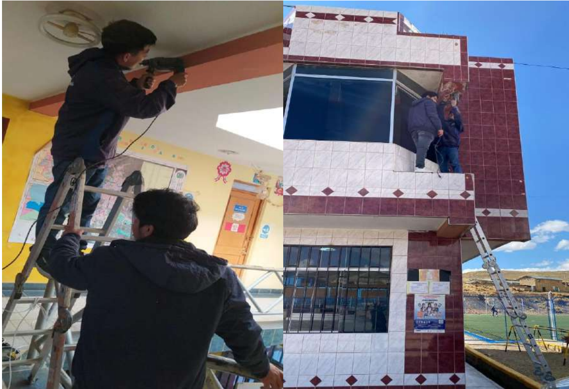
Figura 18. Colocando el cableado UTP en las canaletas respectivas
