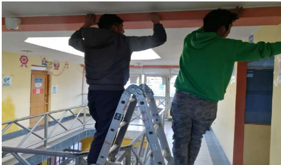
Figura 16. Tendido de canaleta para el cableado UTP
