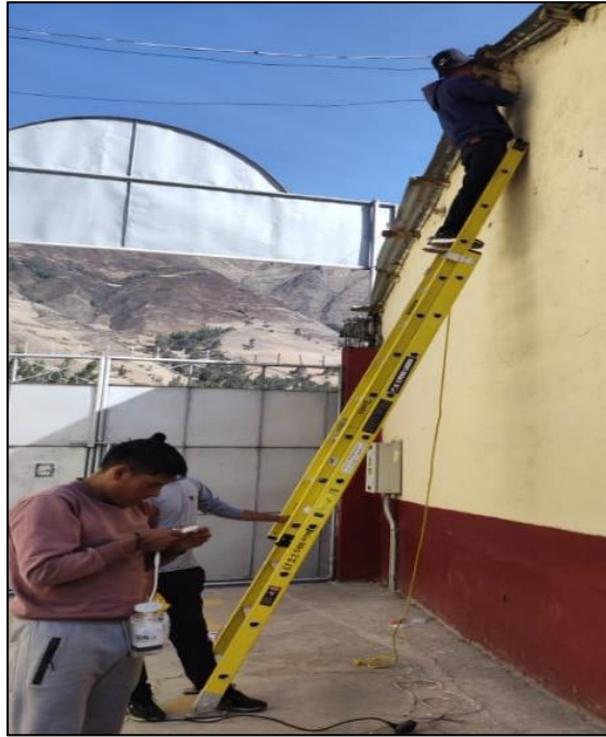
Figura 14: Instalación de la cámara 01 en la entrada principal
