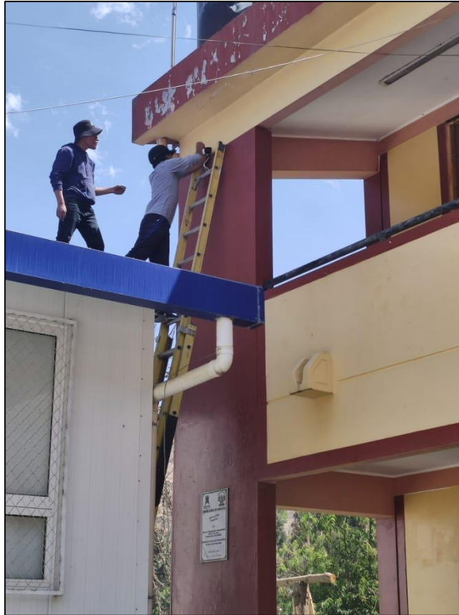
Figura 16: Instalación de la otra cámara.
