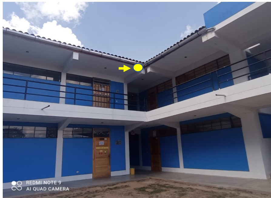
Figura 3: Punto estratégico para la instalación de la cámara 3
