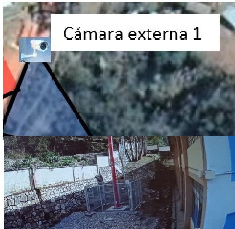
Figura 7: Primer punto de instalación de cámaras de seguridad externa
