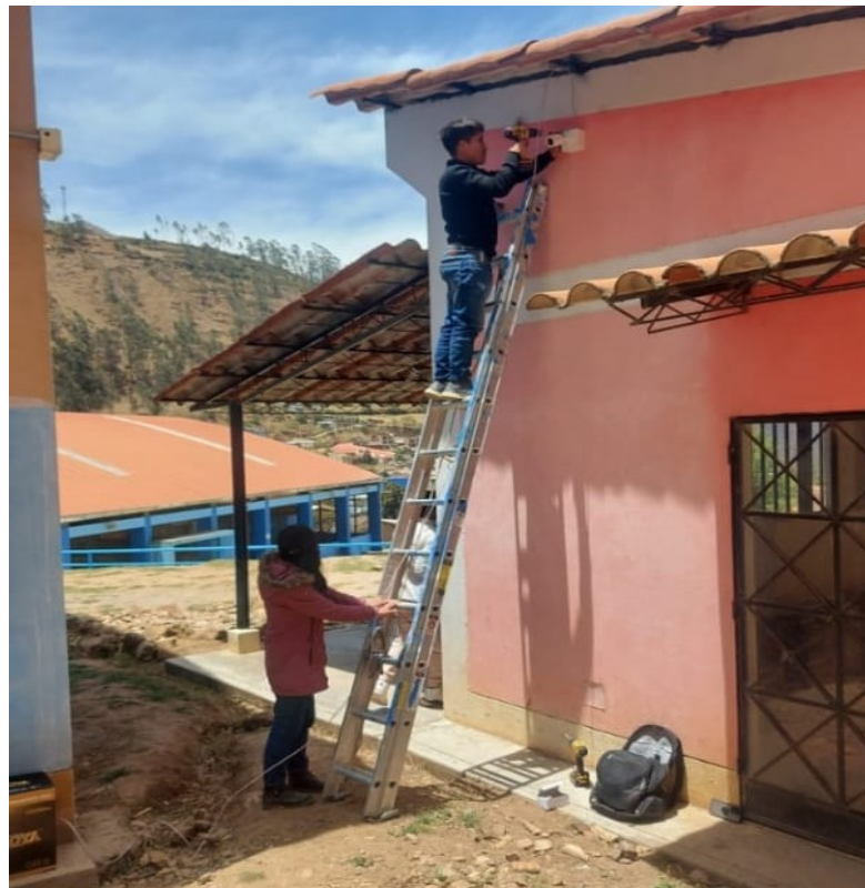
Figura 12: instalación de la cámara numero 1
