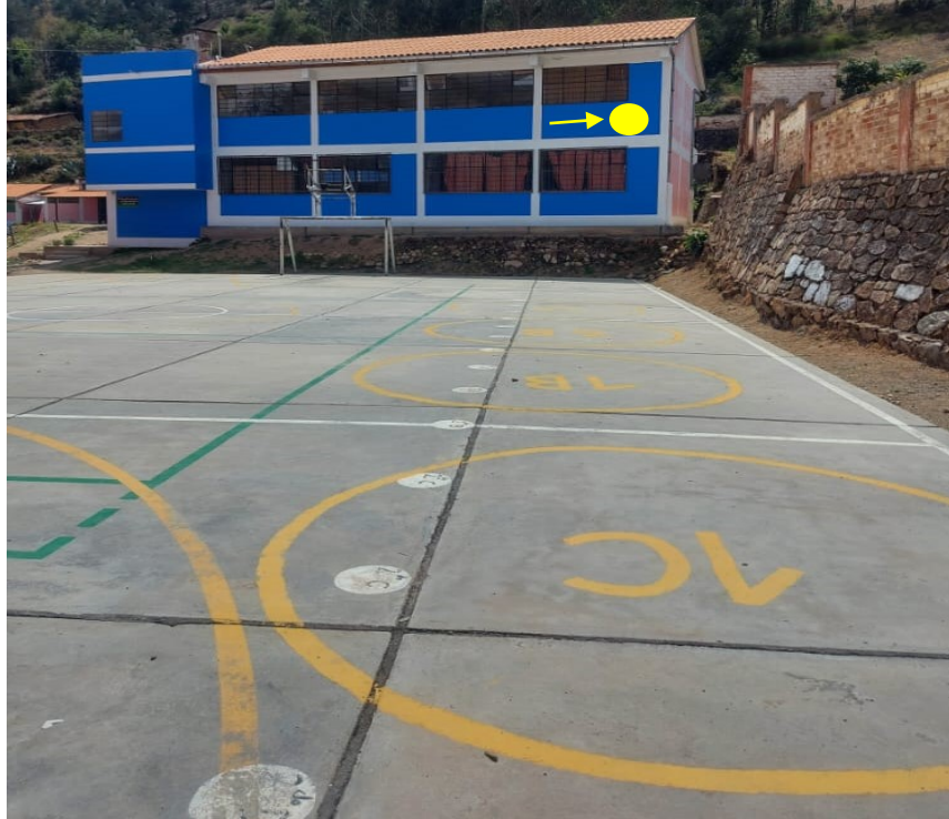
Figura 4: Punto estratégico para la instalación de la cámara 4
