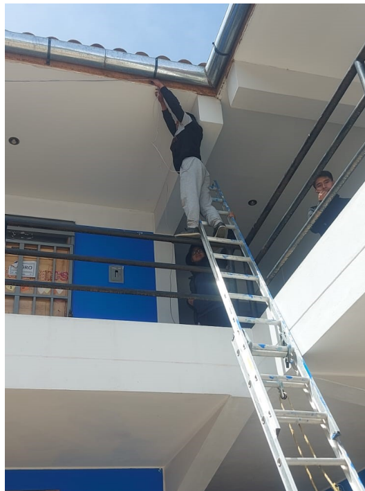
Figura 18: instalación de la cámara 3
