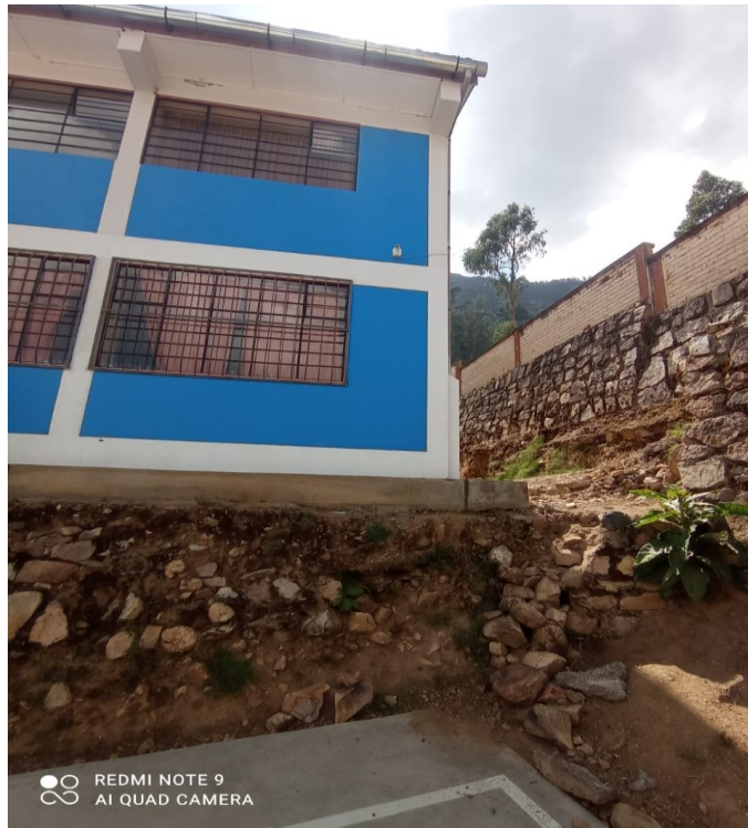
Figura 22: Vista general de la cámara 4 instalada
