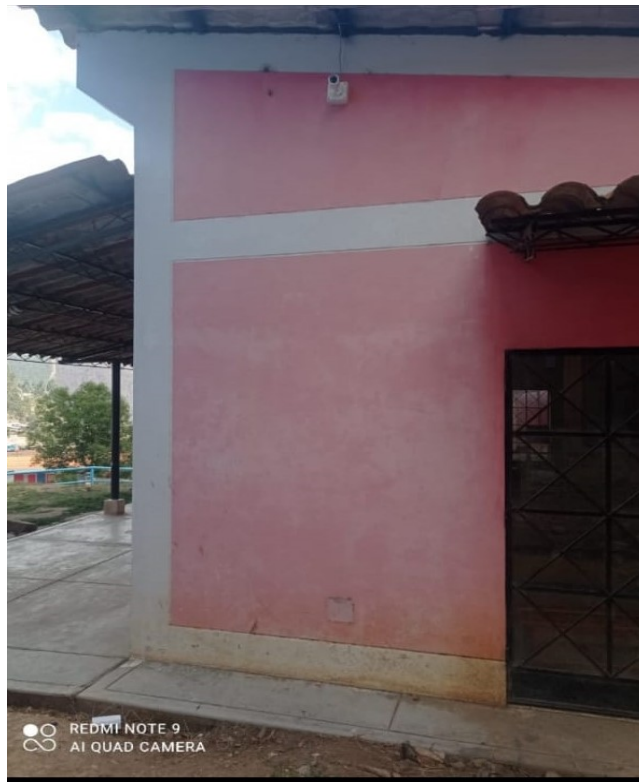
Figura 13: vista de la cámara 1 ya instalada
