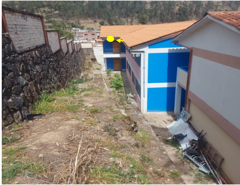
Figura 2: Punto estratégico para la instalación de la cámara 2
