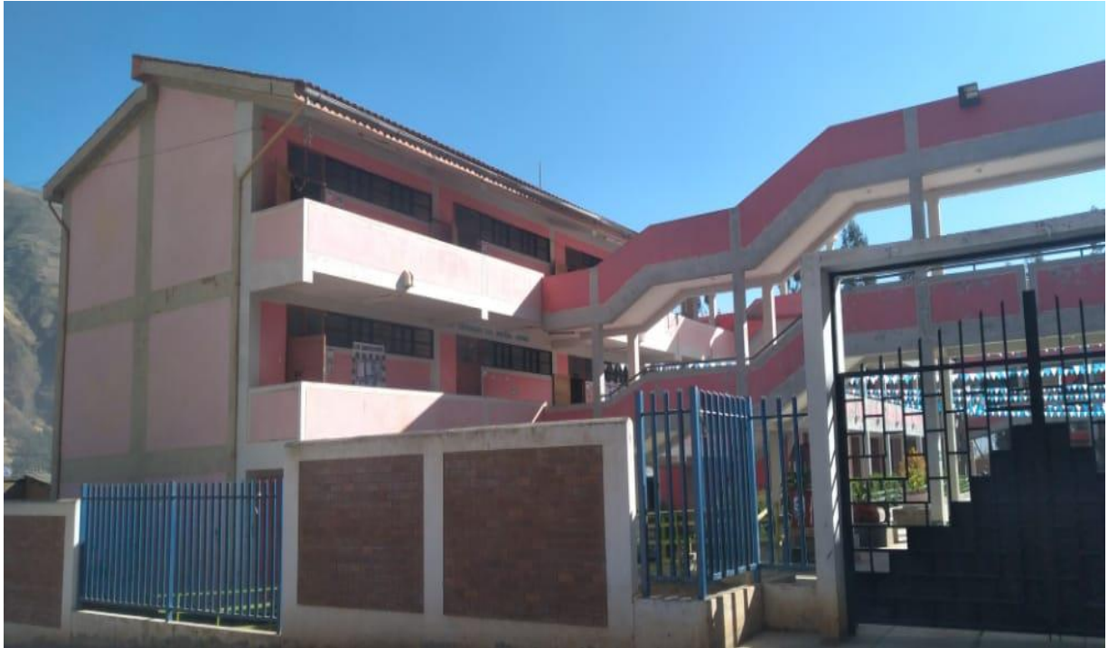
Figura 8 Ejecución del proyecto
