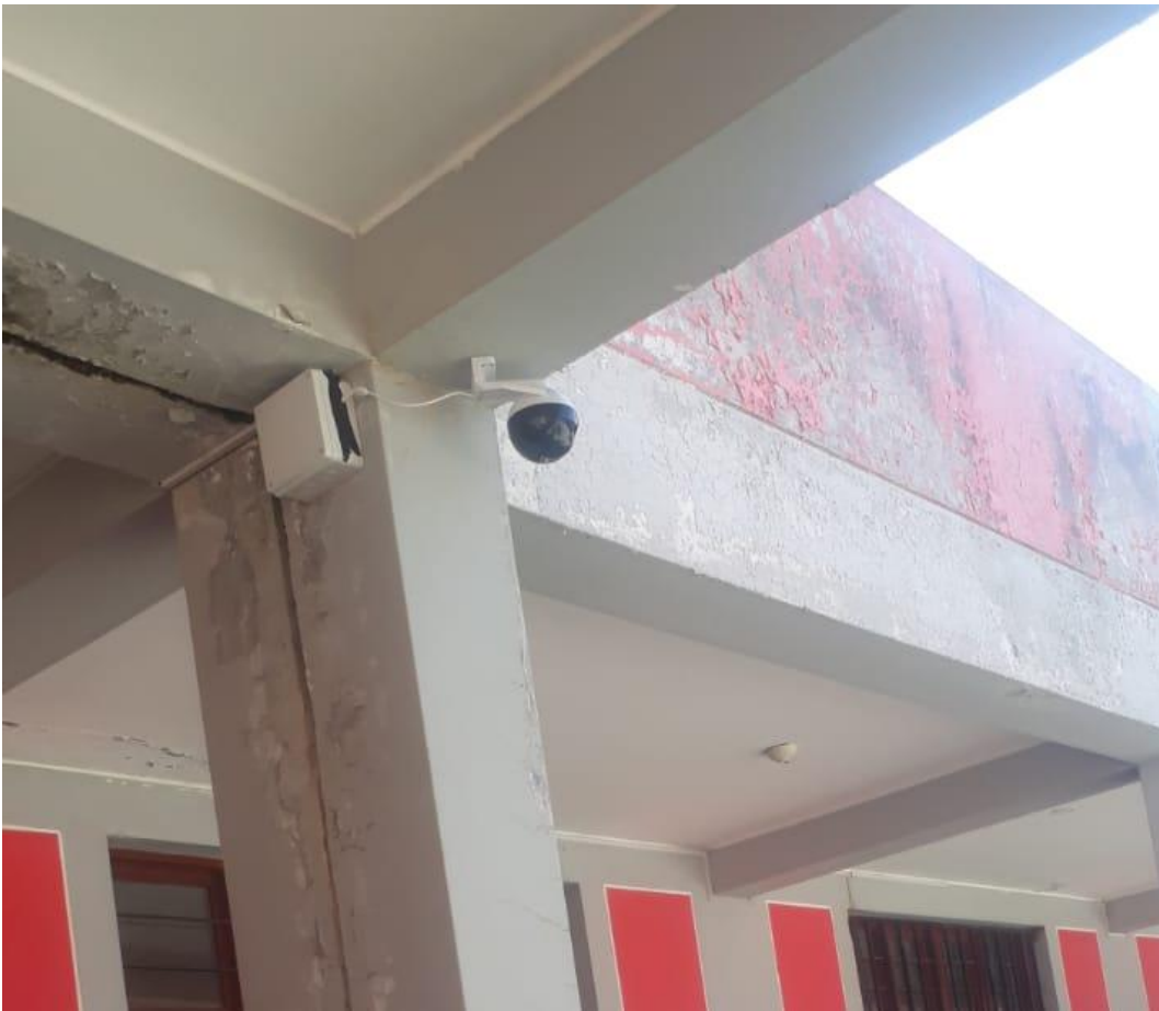
Figura 15 Instalación y puesta en marcha.
