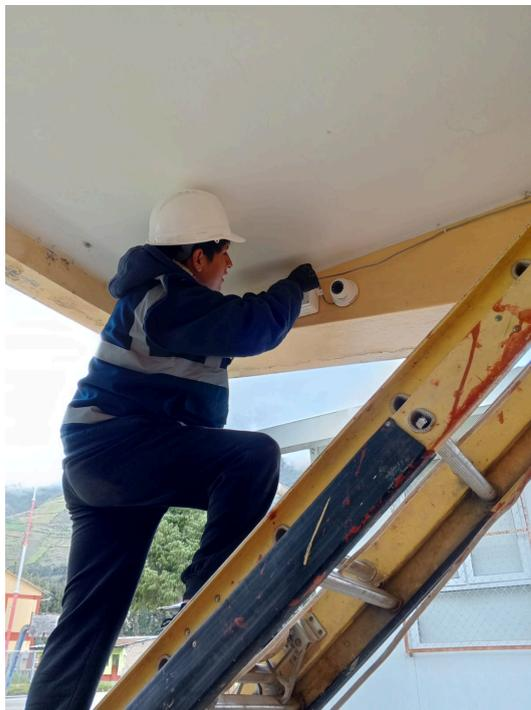
*figura 16: instalando las cámaras*
