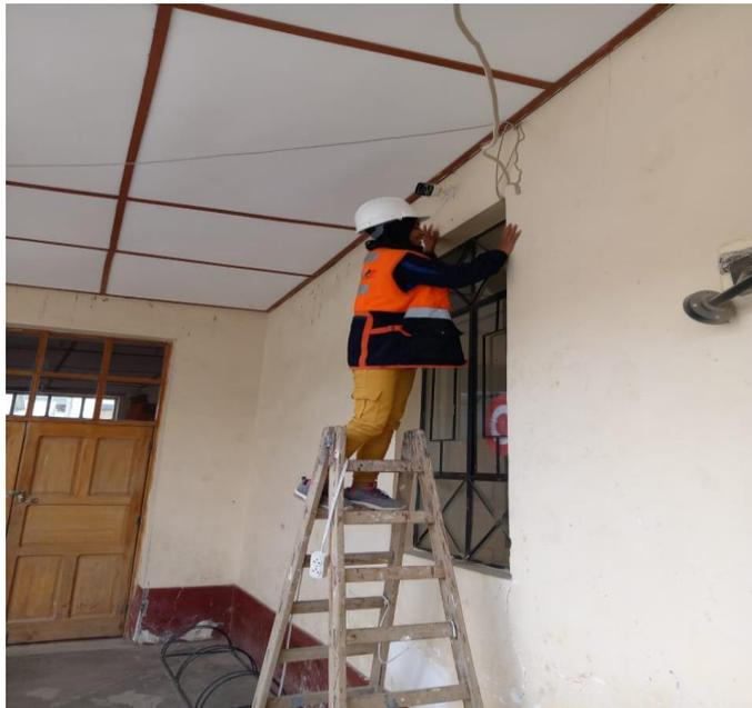
*Figura 9 Instalación de la cámara 01 en la entrada principal de la escuela*
